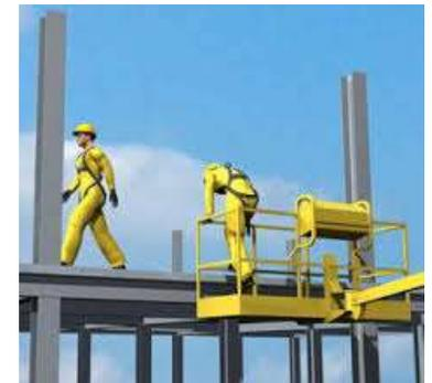
7. Durante le operazioni di sbarco/imbarco, **la cesta dovrà trovarsi sopra al piano di sbarco e non a fianco** (si veda schema semplificato riportato di seguito).
